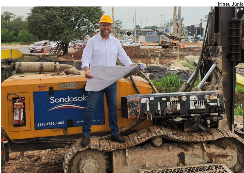
O prefeito acompanhou o andamento dos trabalhos no canteiro de obras
