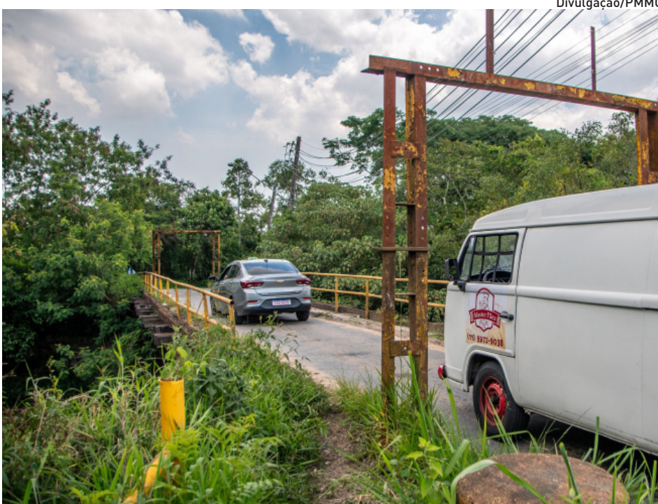
A nova ponte vai completar os trabalhos de recuperação da Estrada da Volta Fria
