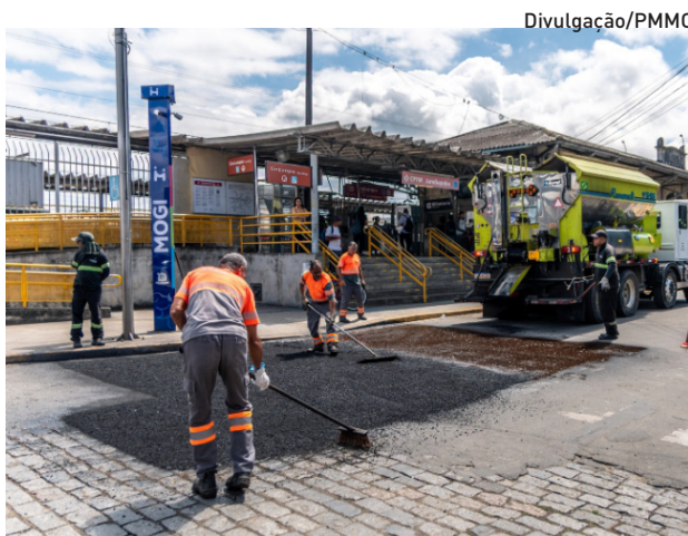
Mutirão de serviços realiza podas, reparos e pinturas
