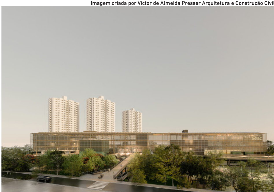
A nova construção vai ampliar o atendimento do Sesc Mogi das Cruzes
